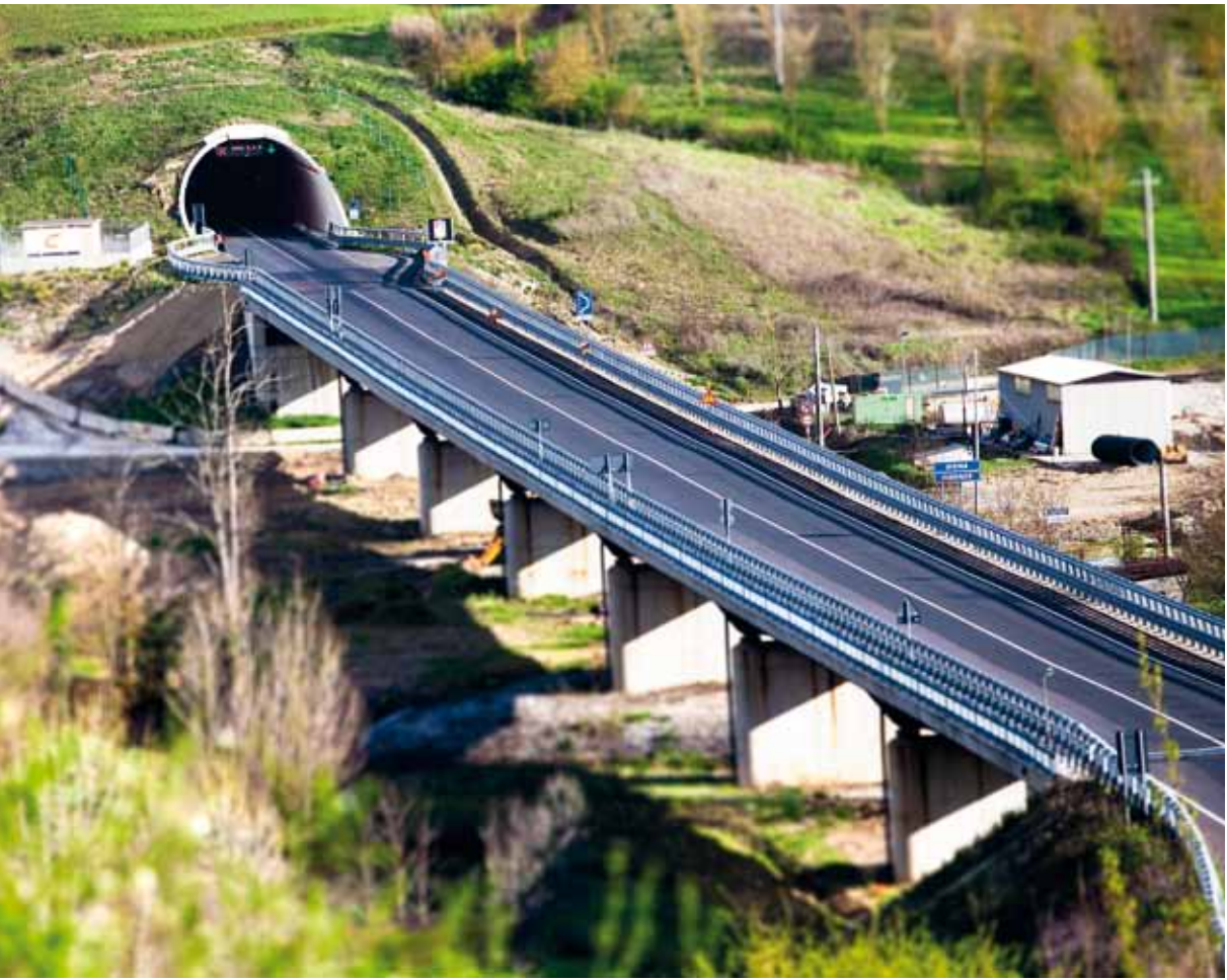
ANAS SpA: lavori di costruzione della Variante di Certaldo, Firenze
