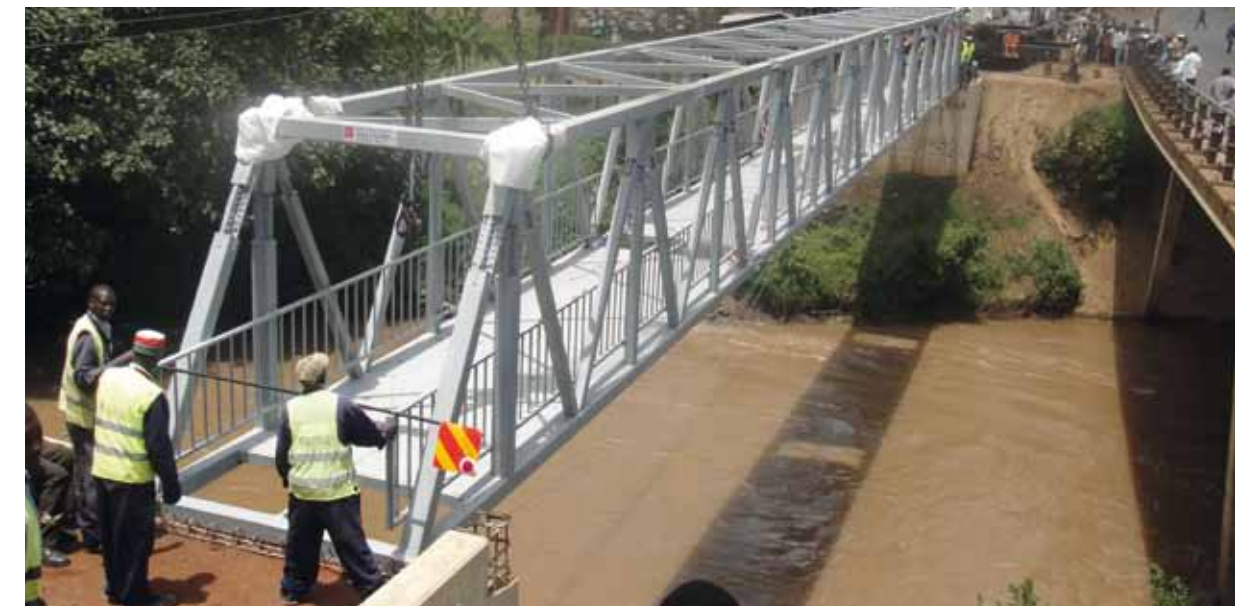
Governo del Kenya - Ministero delle Infrastrutture e dei Trasporti: riabilitazione della strada Eldoret-Turbo-Webuye (A104)
