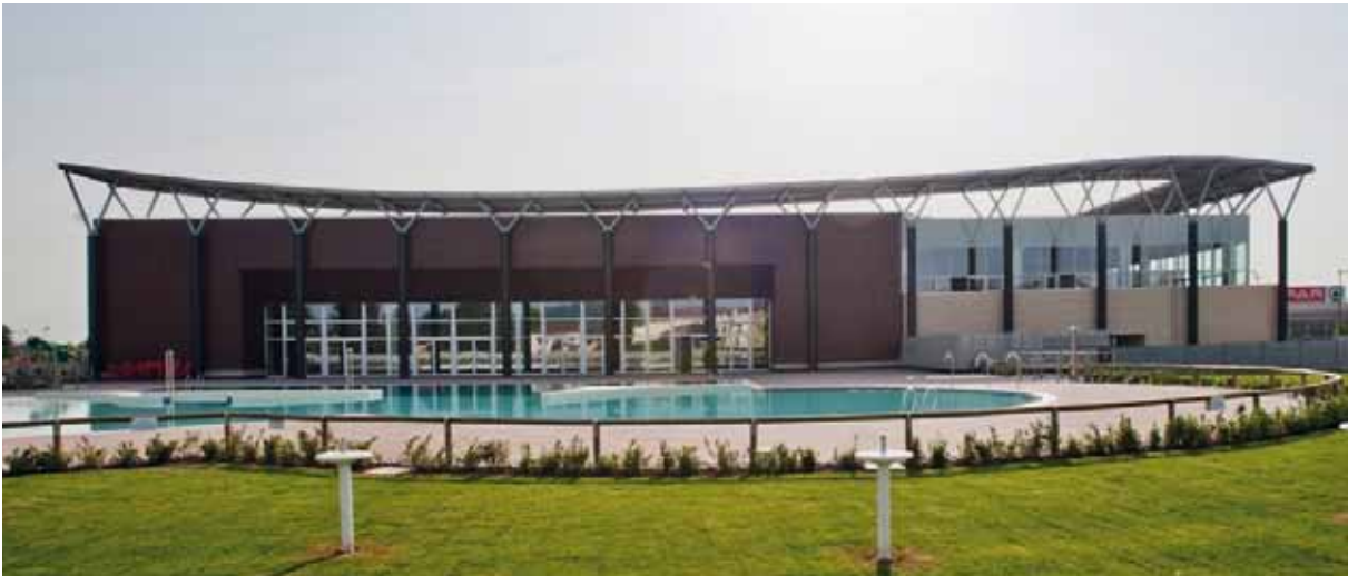
Comune di Caldoggno (VI): nuovo impianto natatorio
