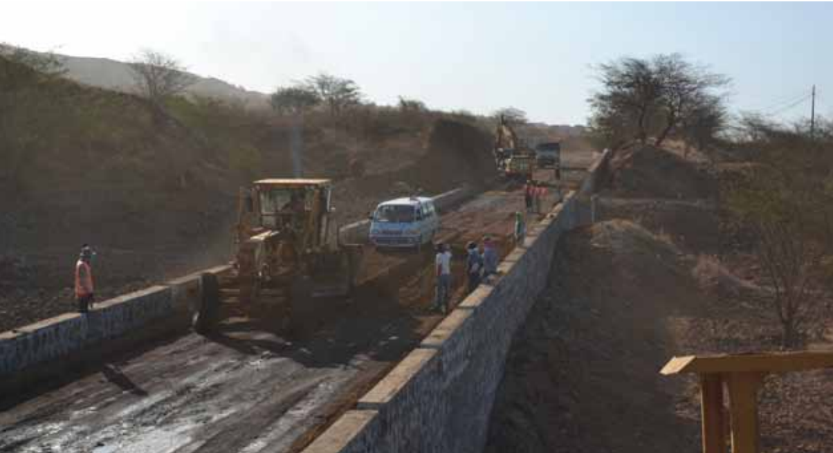
Repubblica di Capo Verde - Ministero delle Infrastrutture, dei Trasporti e del Mare: lavori di riabilitazione della strada circolare inferiore dell'isola di Fogo
