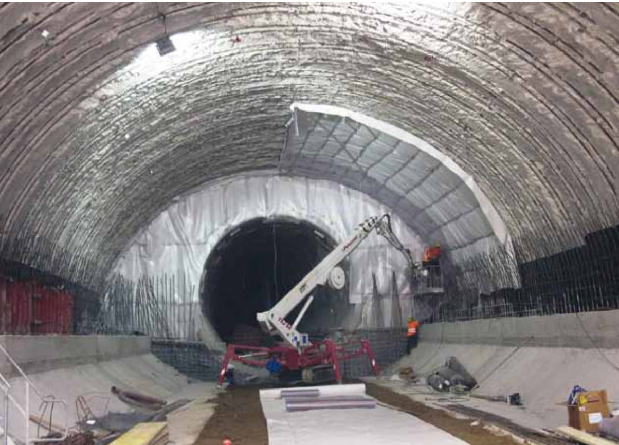
Ansaldo STS SpA: Linea 6 Lotto F - Stazione Chiaia (Metropolitana di Napoli)
