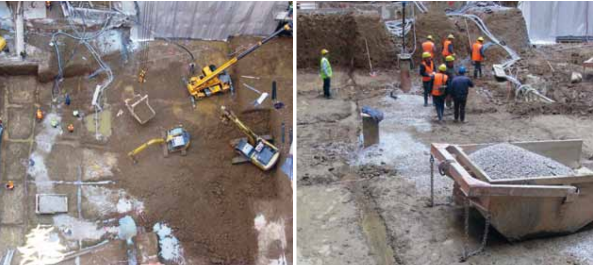
Ansaldo STS SpA: Linea 6 Lotto F - Stazione Chiaia (Metropolitana di Napoli)
