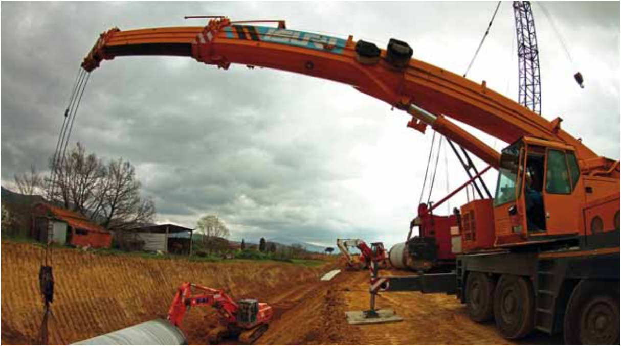
Ente Acque Umbre Toscane: lavori di adduzione primaria dalla diga di Montedoglio alla Valdichiana (AR)
