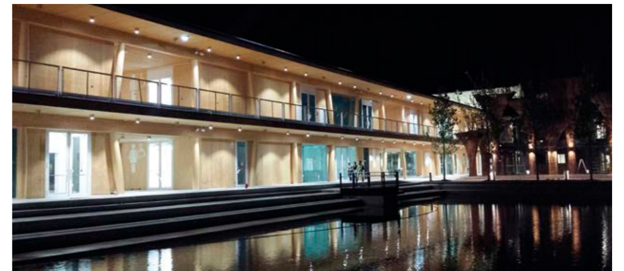
Expo 2015 S.p.A.: progettazione e realizzazione delle Architetture di Servizio – Esposizione Universale del 2015 – Milano
