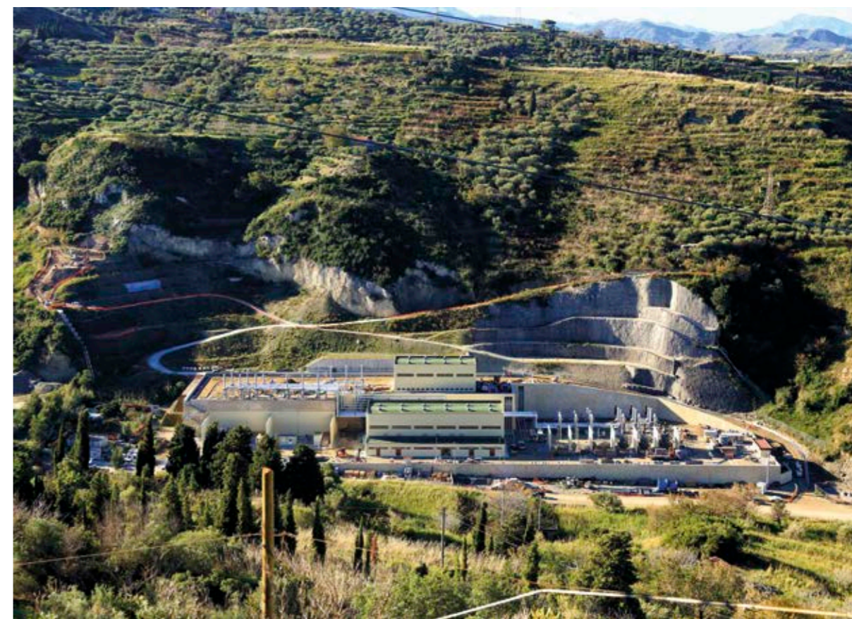
Terna S.p.A.: realizzazione della nuova stazione elettrica di Villafranca Tirrena (ME)
